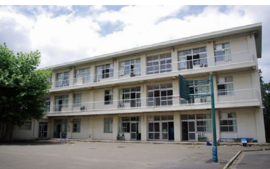
中学HR棟(4号館)
