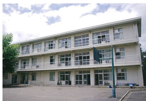
中学HR棟(4号館)
