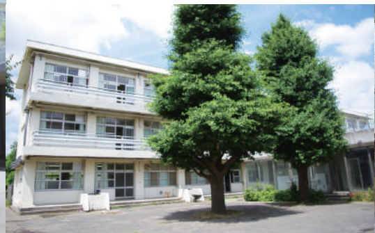
高校HR棟(2号館)・高校ロッカールーム
